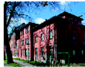
Teil der ehemaligen Bakelite GmbH in Erkner. Hier soll das Chemie-Museum entstehen.
